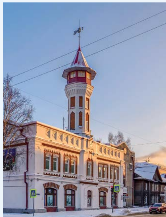
Пожарное депо, Сыктывкар
